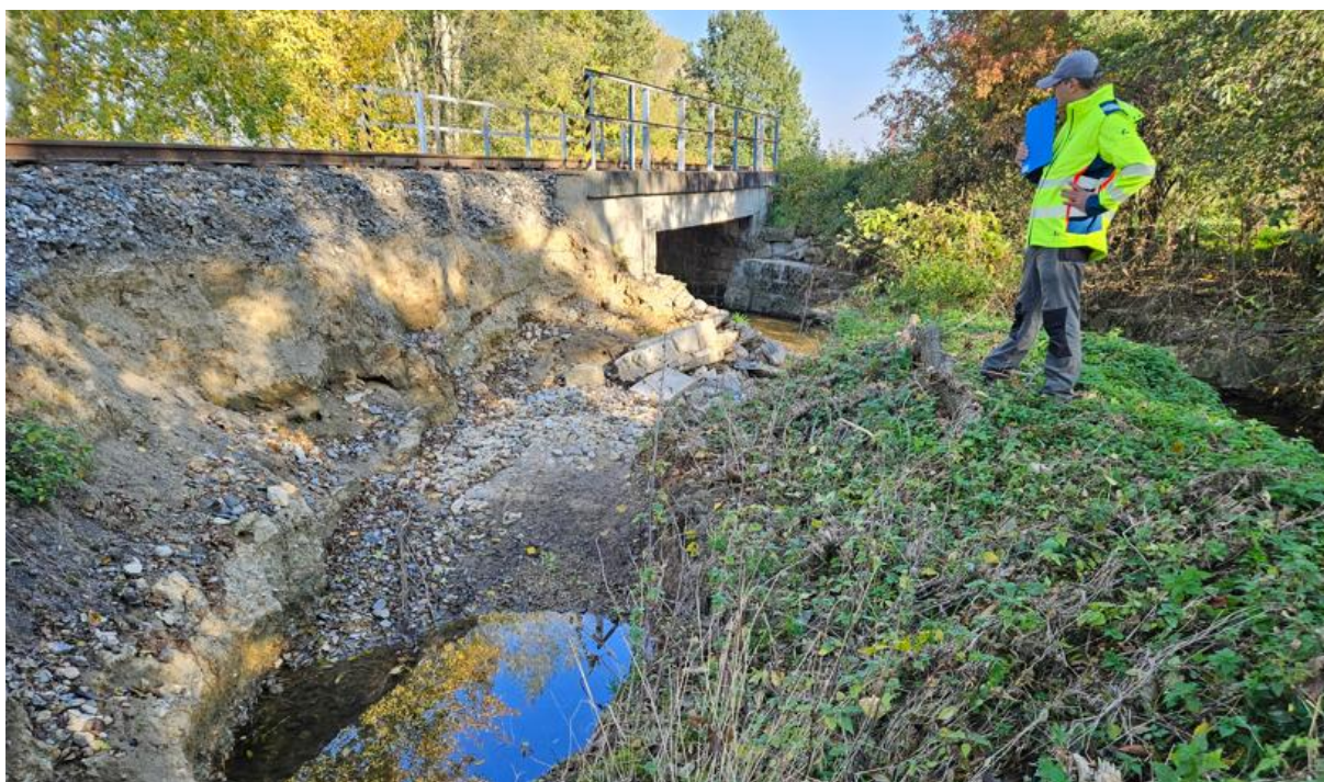
Obrázek 2. Odplavený, pobořený levobřežní svahový kužel u opěry O2, a stržená výběhová přechodová zídka za křídlem opěry.
