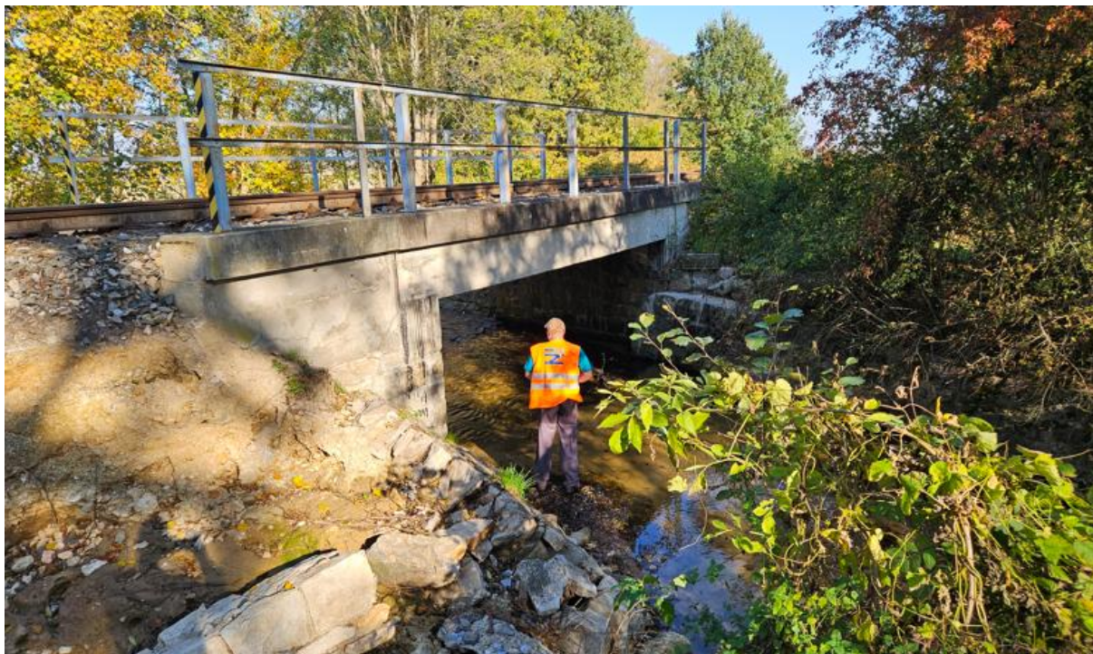
Obrázek 1. Celkový pohled na most a opěru O2, na levé straně O2 je viditelná poškozená, zbořená svahová kužel. Přechodová zídka a opevnění svahu strženo povodněmi.
